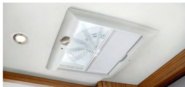
V3009011 Ventilator boven keuken
